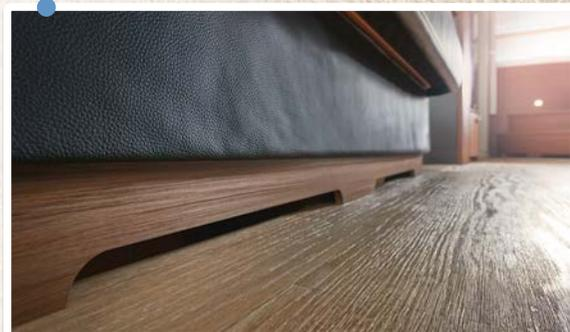
Le chauffage dans le double plancher protège toutes les installations du froid. En même temps, le double plancher emmagasine la chaleur et la restitue de la même manière qu'un chauffage au sol sur le plancher.
