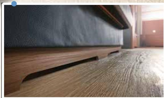
Les convecteurs de chaleur installés dans le double plancher protègent toutes les installations du froid. Dans le même temps, le double plancher emmagasine la chaleur, qu'il restitue à la manière d'un chauffage au sol. En option, vous pouvez également vous équiper d'un réel chauffage au sol.
