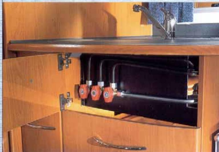
*Die Gasabsperrhähne sind leicht zugänglich im Küchenfach untergebracht.*
