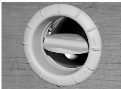
Fig. 60 : Buse d'air chaud, ouverte
