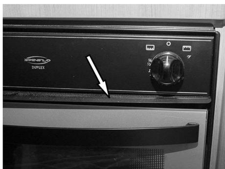
Fig. 136 : Bouclier thermique
