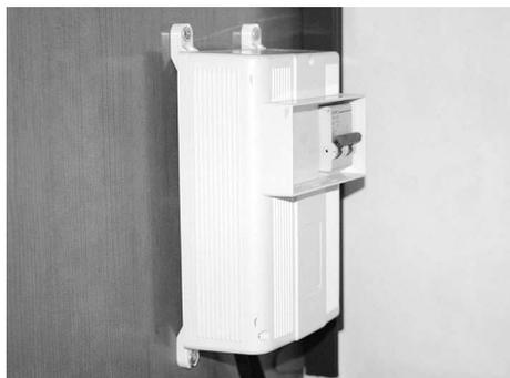
Fig. 43 : Interrupteur principal (Disjoncteur différentiel).
