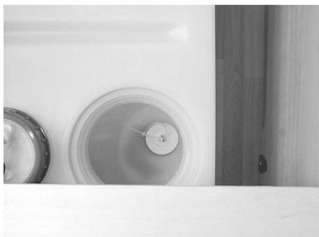
Fig. 102 : Bouchon de vidange du réservoir d'eau propre
