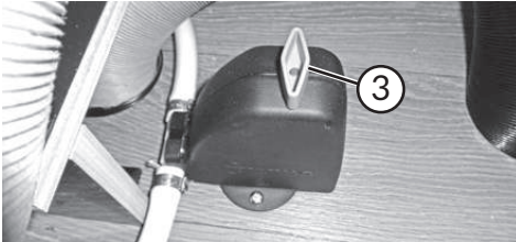
Soupape de sécurité pour chauffe-eau (FrostControl)
