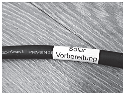
Préparation du câble installation photovoltaïque
