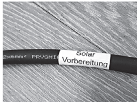
Préparation du câble installation photovoltaïque
