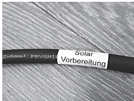
Préparation du câble installation photovoltaïque
