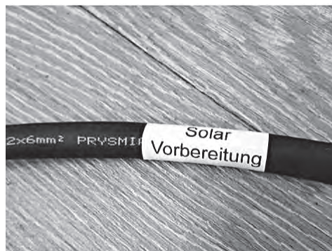
Préparation du câble installation photovoltaïque
