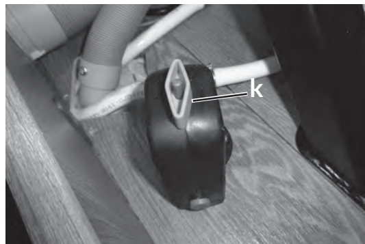
Soupape de sécurité pour chauffe-eau (FrostControl)
