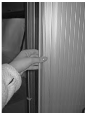
Porte roulante dans le cabinet de toilette
