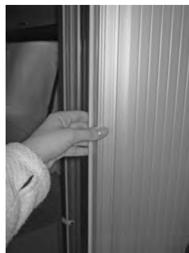
Porte roulante dans le cabinet de toilette
