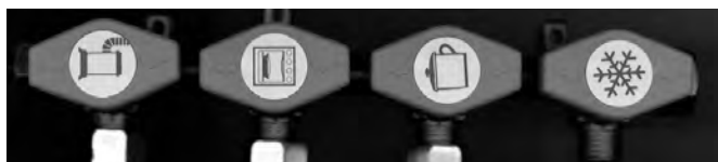
Chauffage Four Cuisinière à gaz Réfrigérateur
