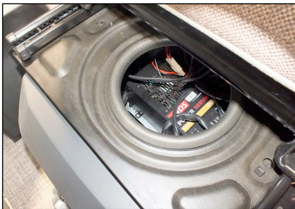
Chargeur de batterie sous le siège conducteur (exemple)
