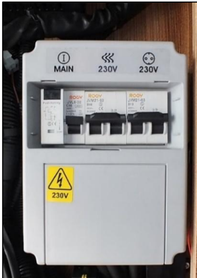
230 V -Absicherung mit FI-Schutzschalter (Abb. beispielhaft)
