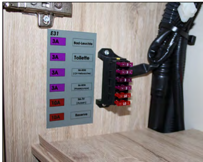
Porte-fusible supplémentaire sous le lavabo (exemple)
