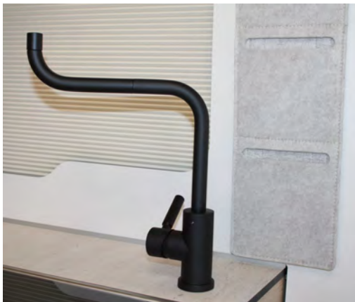
Einhebel-Misch Armatur in der sog. „Anti-Tropf-Stellung“
