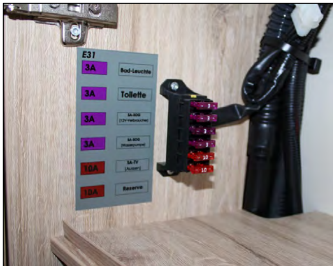
Zusatz-Sicherungshalter unter dem Waschbecken (Abb. beispielhaft)
