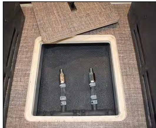
Anschlüsse der ALDE-Fußboden-Heizmatte (Abb. beispielhaft)
