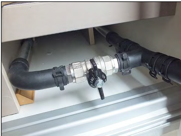
Vanne d'activation du chauffage du réservoir d'eaux usées (exemple)
