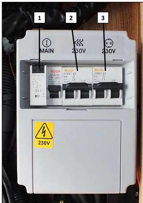
Coupe-circuit 230 V avec disjoncteur différentiel (exemple)
