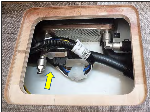
Échangeur thermique Alde (exemple)
