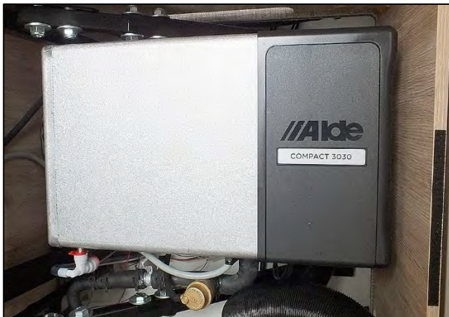
Gasbetriebene Heizung ALDE Compact (Abb. beispielhaft)
