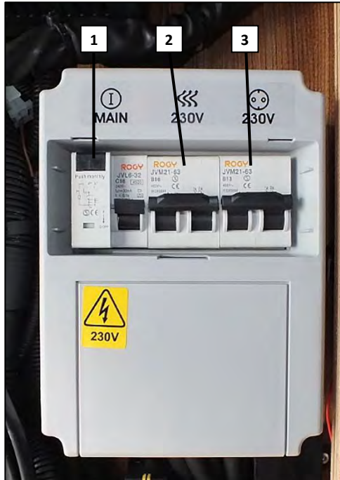
230 V -Absicherung mit FI-Schutzschalter (Abb. beispielhaft)
