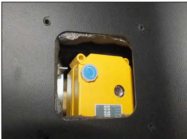
Vanne électrique pour la vidange du réservoir d'eaux usées (exemple)
