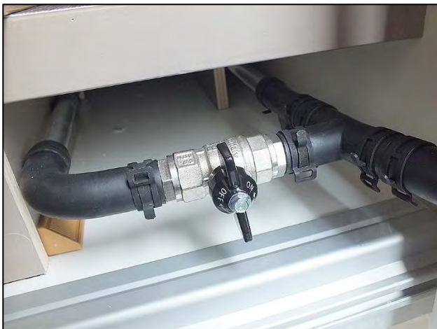
Ventil zum Aktivieren der Abwassertank-Beheizung (Abb. beispielhaft)
