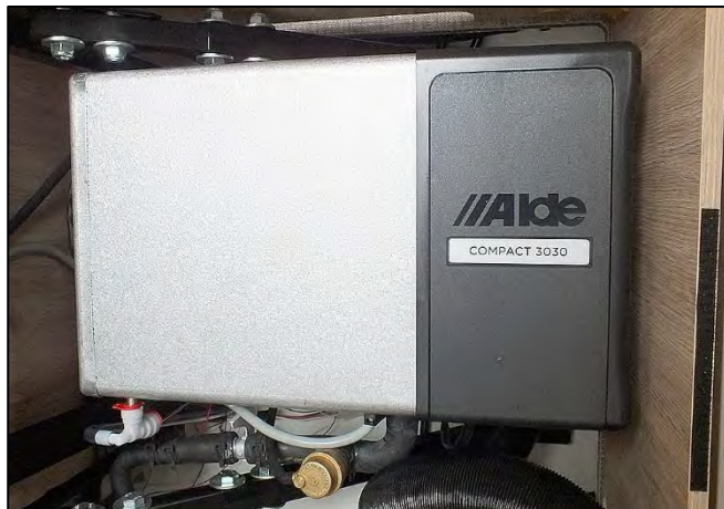
Chauffage au gaz ALDE Compact (exemple)
