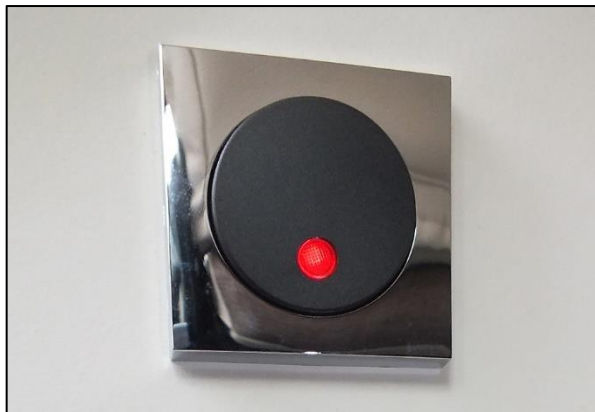
Interruttore per il riscaldamento del serbatoio delle acque reflue
