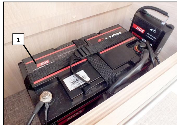
Batterie d'alimentation dans le coffre de lit gauche (exemple)
