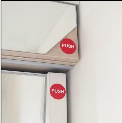
„Push-to-open“ Verschlüsse an den Badmöbeln
