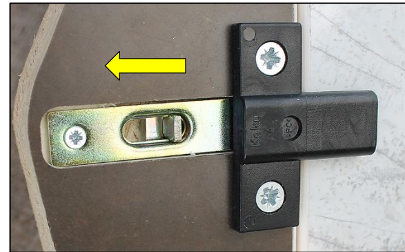
Unterseitiger Schieberiegel zur Arretierung des klappbaren Tischplatten-segments
