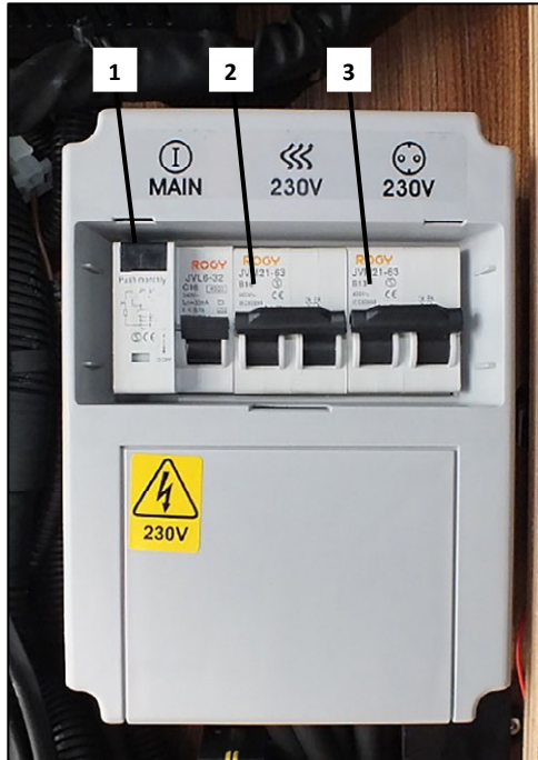
230 V -Absicherung mit FI-Schutzschalter (Abb. beispielhaft)
