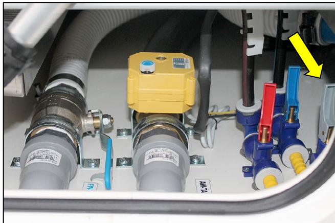
Soupape de vidange pour la réduction du volume d'eau propre à 25 L (exemple)
