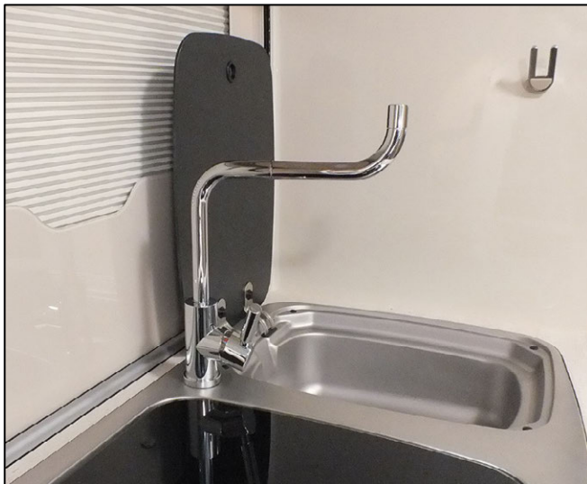
Bec du mitigeur à levier unique en « position anti-gouttes »
