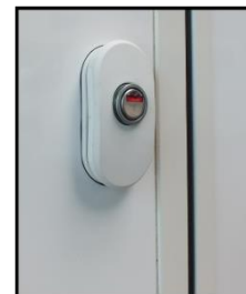
Serviceklappe verriegelt aber nicht verschlossen (Der Zylinder steht hervor)
