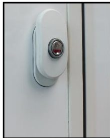
Trappe de service déverrouillée
