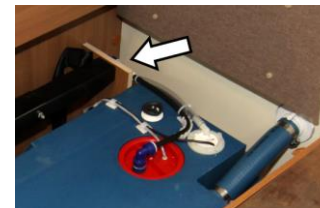
Posto di montaggio valvola regolatrice della pressione
