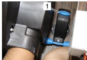
Vanne de sécurité / de vidange FrostControl
