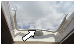
Toit ouvrant fermé
