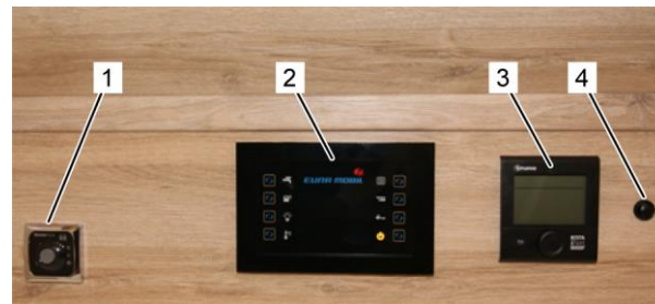
Bedienelemente oberhalb der Aufbautür
