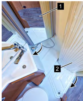
Trasformazione in cabina doccia
