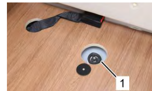
Rubinetto di scarico serbatoio dell'acqua sanitaria
