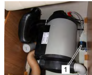
Ventil FrostControl öffnen
