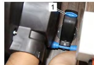
Aprire la valvola di scarico/di sicurezza FrostControl
