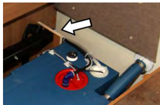
Posto di montaggio valvola regolatrice della pressione
