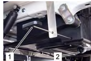
Réservoir d'eaux usées
