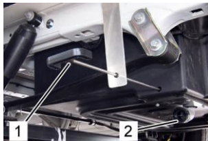
Serbatoio acque grigie
