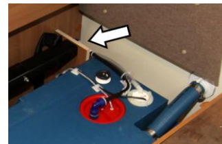
Posto di montaggio valvola regolatrice della pressione
