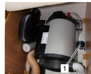
Sicherheits-/Ablassventil FrostControl
