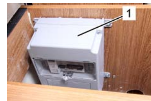
Sicherungsautomat 230 V
