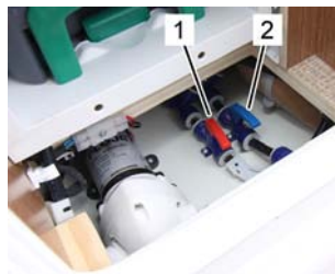
Ablasshähne Leitungssystem
