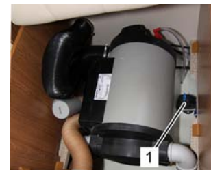
Vanne de sécurité / de vidange FrostControl
