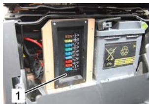
Scatola dei fusibili 12 V
