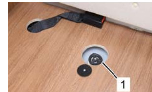
Rubinetto di scarico serbatoio dell'acqua sanitaria
