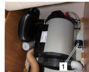
Aprire la valvola di scarico/ di sicurezza FrostControl
