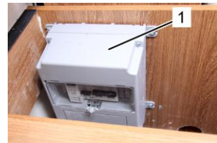
Automate de sécurité 230 V
