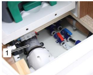
Robinet de vidange de la tuyauterie
