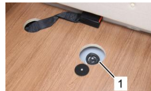
Rubinetto di scarico serbatoio dell'acqua sanitaria
