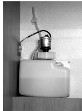
Serbatoio di compensazione
