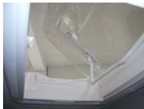
Oblò a soffitto aperto
