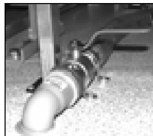
Vanne de vidange des eaux usées, fermée / ouverte
