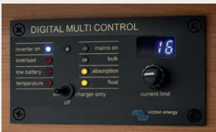
» Convertisseur / chargeur Victron „Multiplus“ avec panneau de commande, Victron PowerAssist et Powercontrol (en option)
