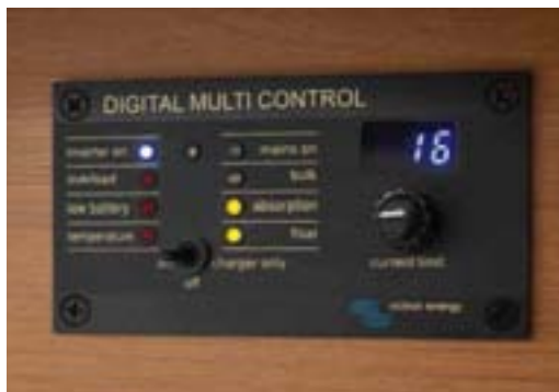
+ Centrale de distribution électrique Victron (en option) (4)
