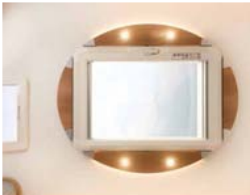
+ Grand lanterneau avec habillage et éclairage
