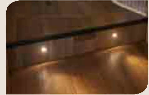
► Eclairage de la contre marche pour plus de sécurité
