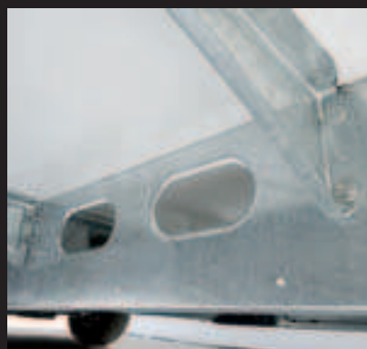
Habillage du plancher en fibres de verre
