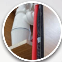
Le condutture idriche sono disposte lungo il doppio pavimento quindi non sottraggono spazio all'ambiente interno. L'acqua di recupero viene raccolta tramite un sifone dotato di un sistema di tubature antiodore in un serbatoio appositamente concepito.
