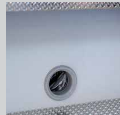
Particolare del doppio pavimento: bocchetta d'aerazione nell'intercapedine
