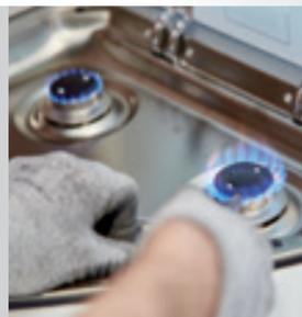
Vérification de le bon fonctionnement du circuit de gaz.
