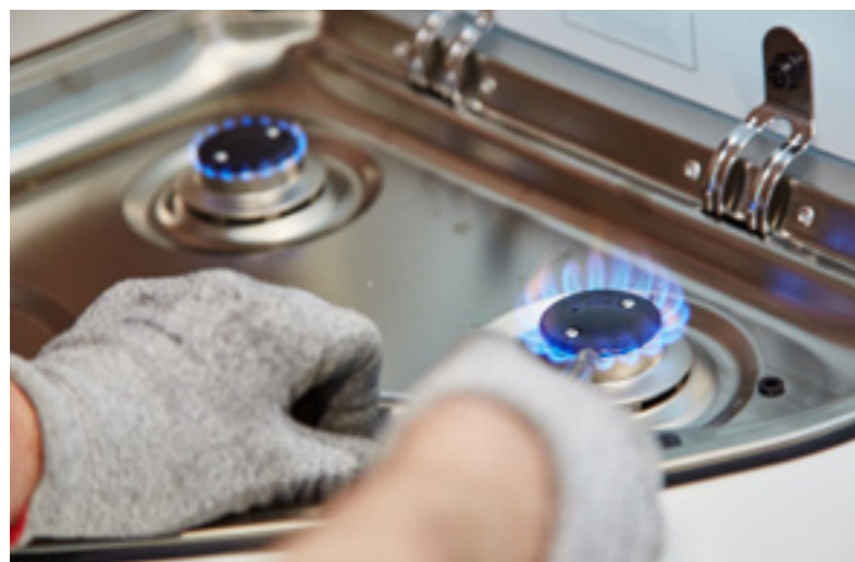
Essais de fonctionnement des conduites de gaz
