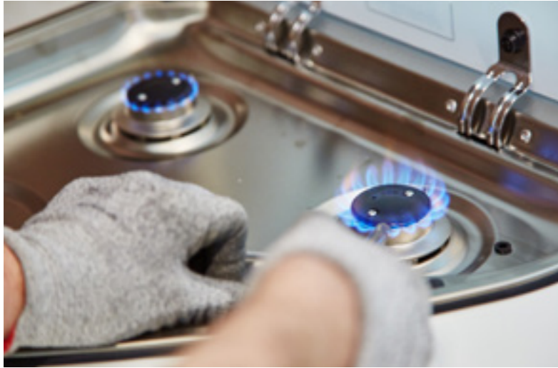
Essais de fonctionnement des conduites de gaz
