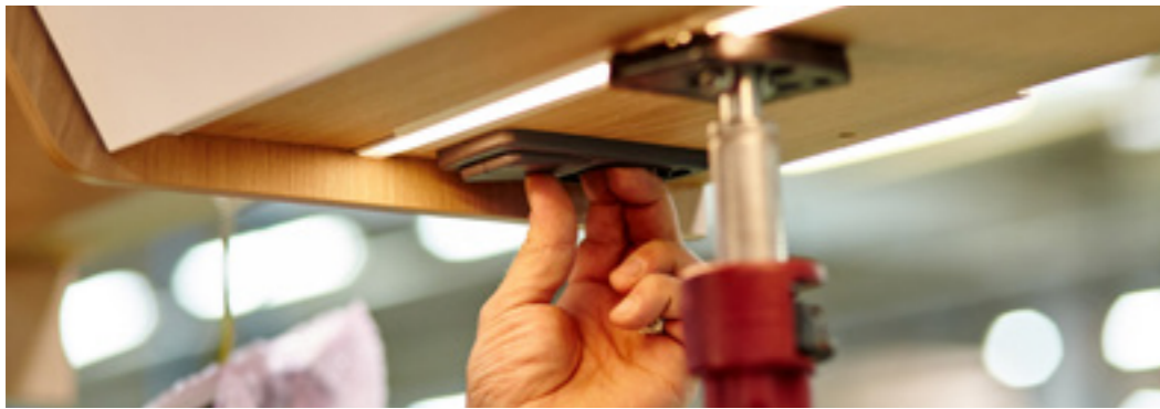
Vérification du fonctionnement et de l'installation conforme des systèmes électriques
