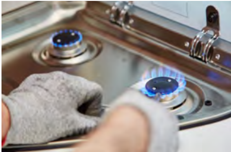
Essais de fonctionnement des conduites de gaz
