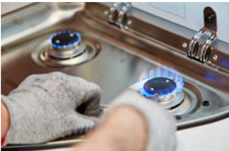
Essais de fonctionnement des conduites de gaz
