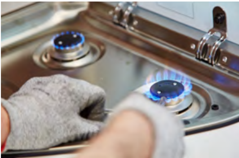
Essais de fonctionnement des conduites de gaz
