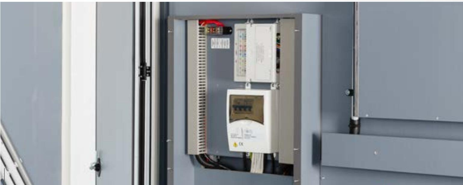
Le tableau de distribution électrique, facile d'accès - il contient le chargeur, les fusibles et le disjoncteur.
