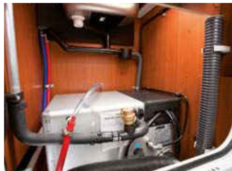
Chauffage Polar FRANKIA (option pour Compact/Holiday/ComfortClass): chauffage à eau chaude avec chauffage auxiliaire châssis
