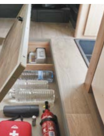
Trappe accès au double plancher
