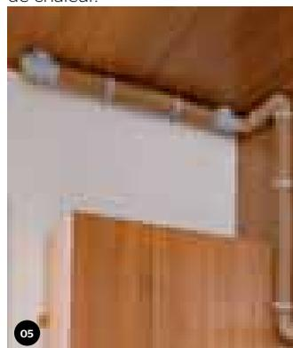
**Les tuyaux de chauffage** sont installés de manière à chauffer le plancher.
