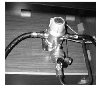
**Installation de gaz Duo Control**, changement automatique de la bouteille de gaz vide à la bouteille pleine, avec protection anti-gel
