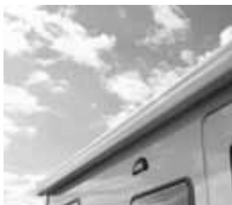
Sotre mécanique au niveau de la porte
