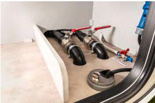
VANNES D'AMENÉE ET D'ÉVACUATION D'EAU
