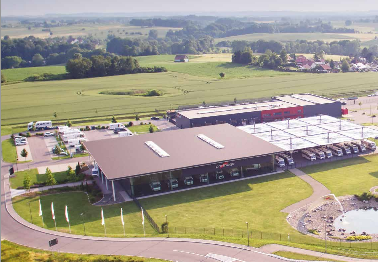
Centrale d'entreprise Carthago à Aulendorf
