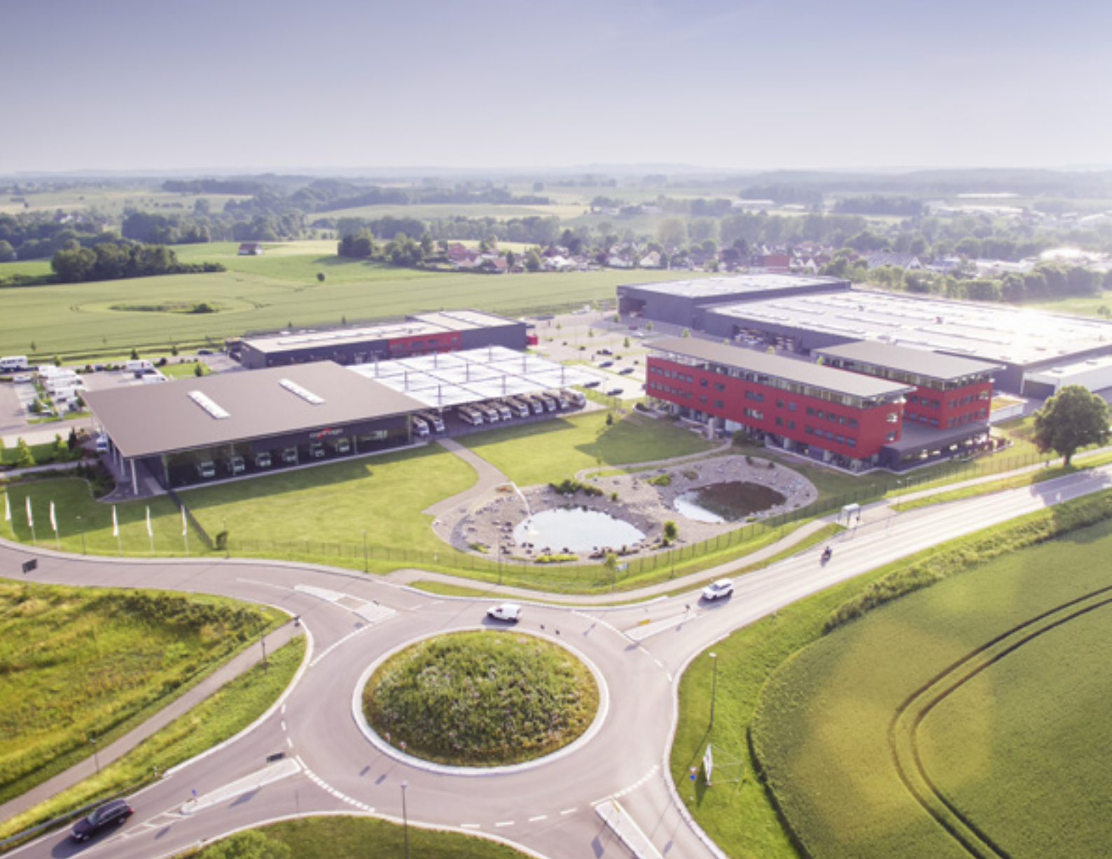
Centrale d'entreprise Carthago à Aulendorf
