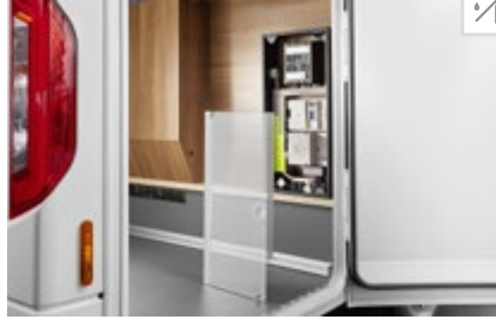
Centrale électrique facilement accessible dans le garage
