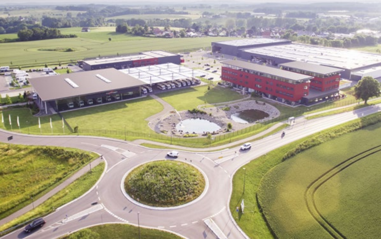
Centrale d'entreprise Carthago à Aulendorf
